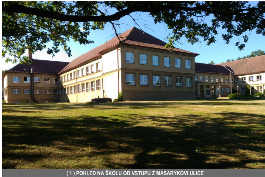
( 1 ) POHLED NA ŠKOLU OD VSTUPU Z MASARYKOVI ULICE
