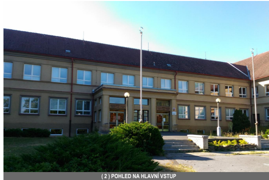
( 2 ) POHLED NA HLAVNÍ VSTUP
