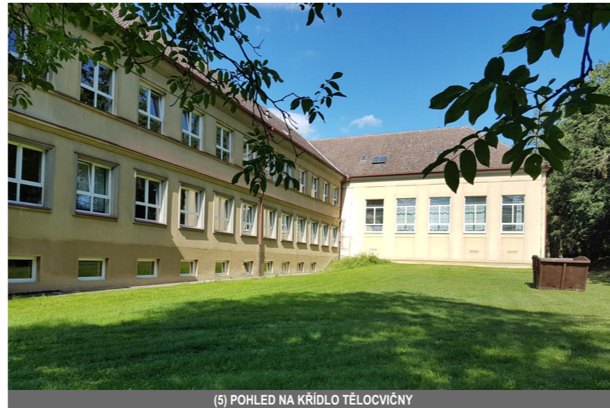
( 5 ) POHLED NA KŘÍDLO TĚLOCVIČNY
