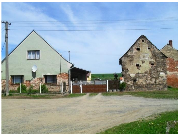
K1 - Objekt staré sýpky, resp. špýcharu v rámci usedlosti č.p. 21 v severní části sídla Mašovice
