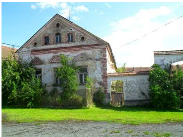
K1 - Venkovská usedlost č.p. 7 na návsi v Bukové
