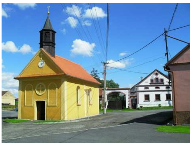
Kaple na návsi v Mezholezích
